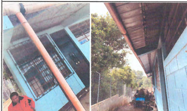
Foto 3: Vista de Canales y Bajadas de Agua Pluvial (BAP); las cuales la EORM prioriza sustituir y mejorar.
